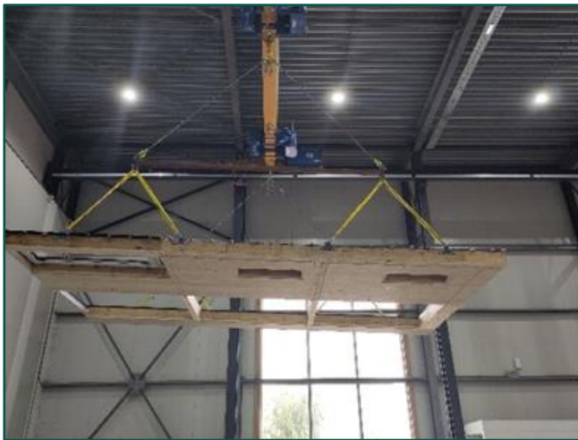
Horizontale plaatsing prefab gevel op het casco.
