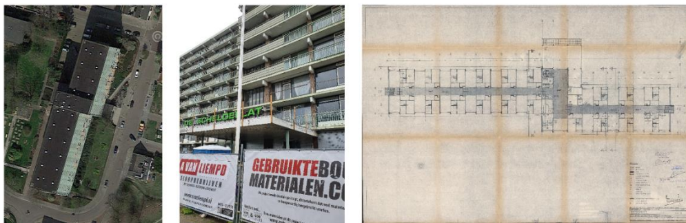
Uitvoerder: A van Liempd Locatie: Borgvlietsdreef 152 – 990, 'Scheldeflat' Omschrijving: demontage van binnenkozijnen die woningen scheiden van galerij
