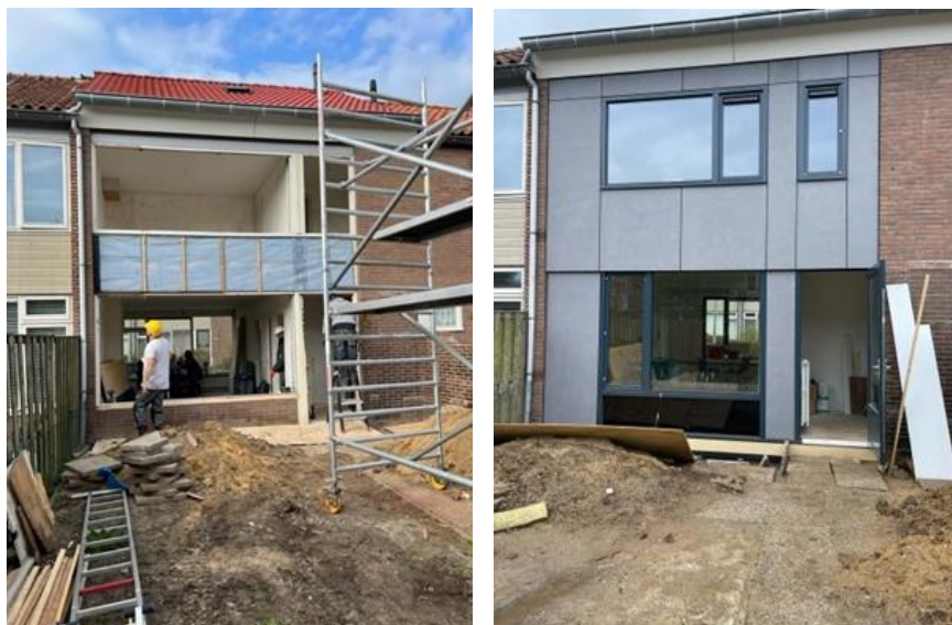
Figuur 34, resultaat voorzetgevel achterzijde
