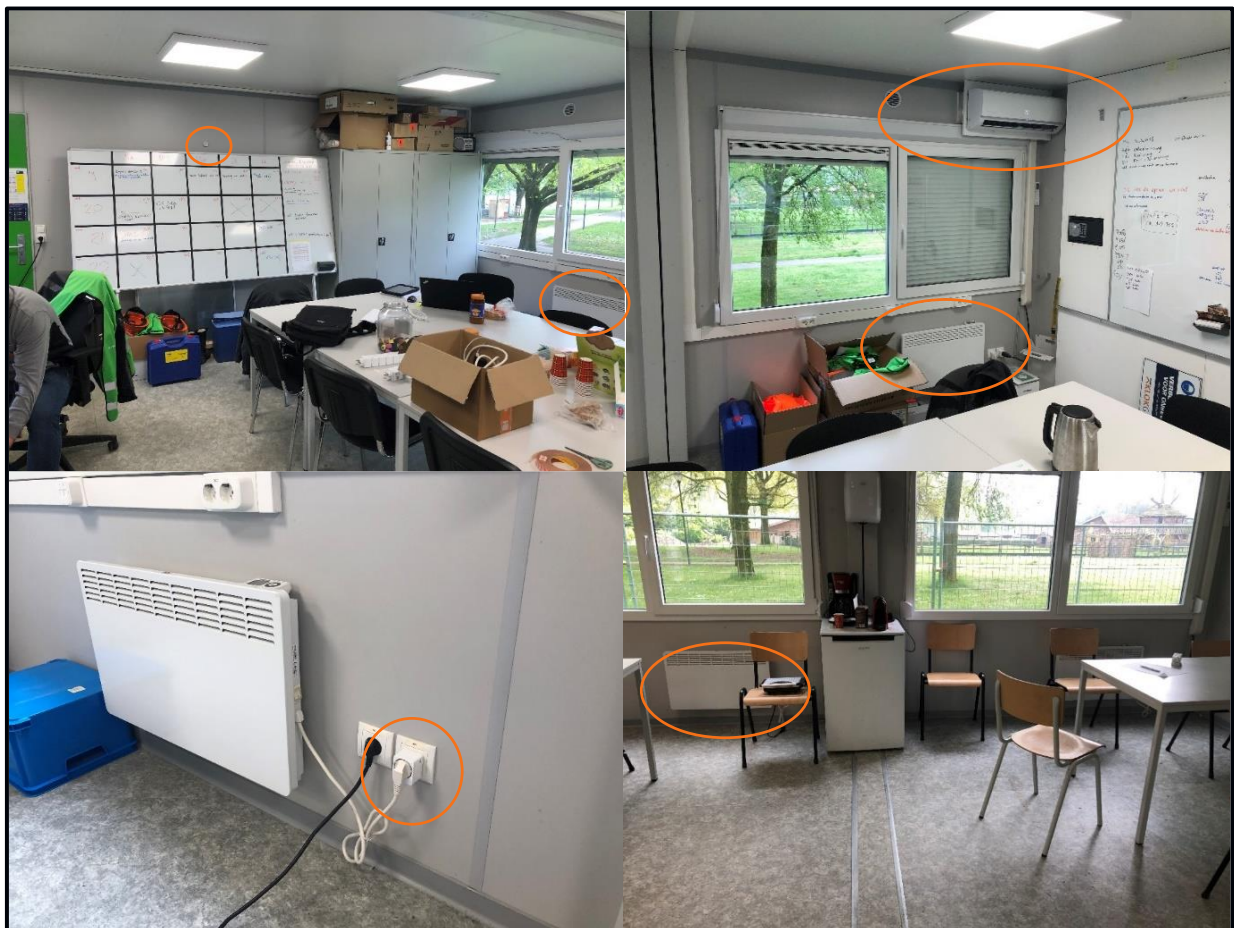
Figuur 3abcd: Kantoor en schaftkeet met temperatuursensoren en smartplugs (tbv elektrische verwarming en airco ed.)
