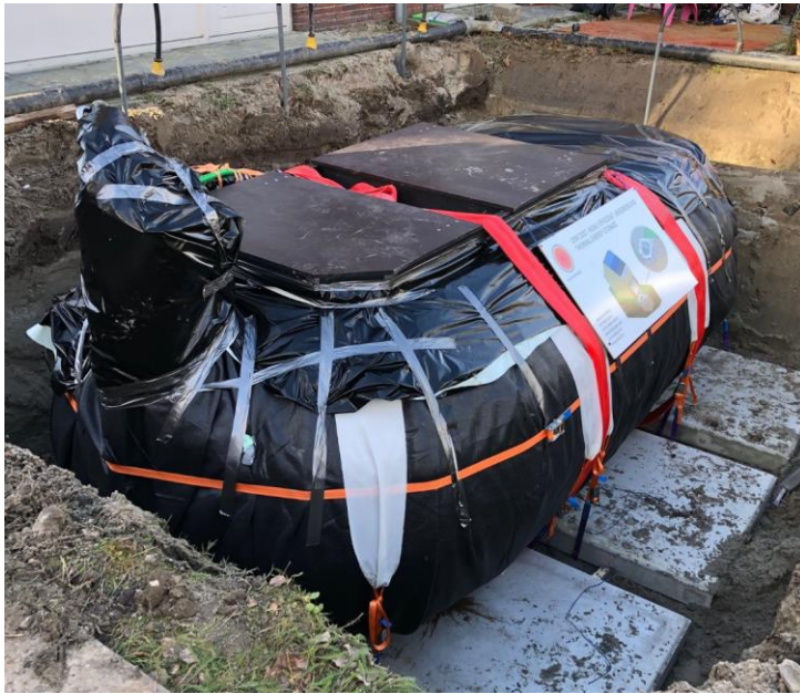
Figuur 3: Ondergrondse warmtebuffer bij de aanleg
