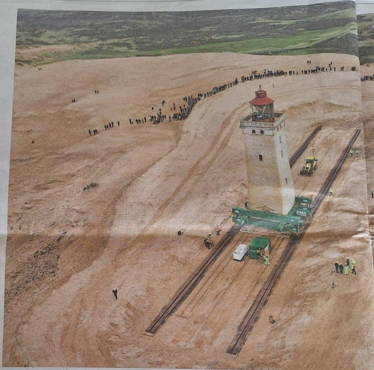
De vuurtoren Knoop van Rudbjerg in Jutland wordt in 2019 op rails verplaatst om verder weg van de Noordzee te komen.
